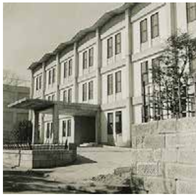
杉並校舎新1号館落成 昭和33年(1958)
